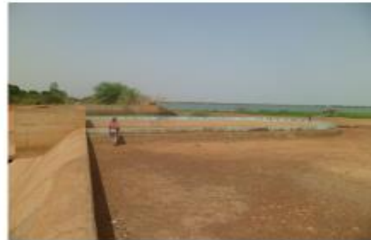
Déversoir et déversoir de sécurité du barrage de Loumbila
