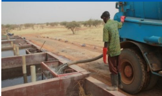
Dépotage des boues à la station de traitement
