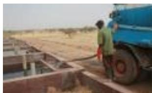
Dans le cadre de sa coopération avec Annecy-le-Vieux, la commune de Dori s'est dotée d'un PGEUE dont la mise en œuvre a permis la construction d'équipements nécessaires au confinement et au traitement des eaux usées et excréta générés par les ménages dont une station de traitement de boues de vidange (STBV).
