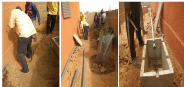
Le dispositif de pédo-épuration est constitué d'un bac décanteur de 0,118 m<sup>3</sup> (118 litres), composés de trois compartiments séparés partiellement par des plaques métalliques.
